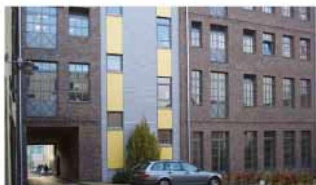
2006 Mittelgebäude Angelburger Straße 74
