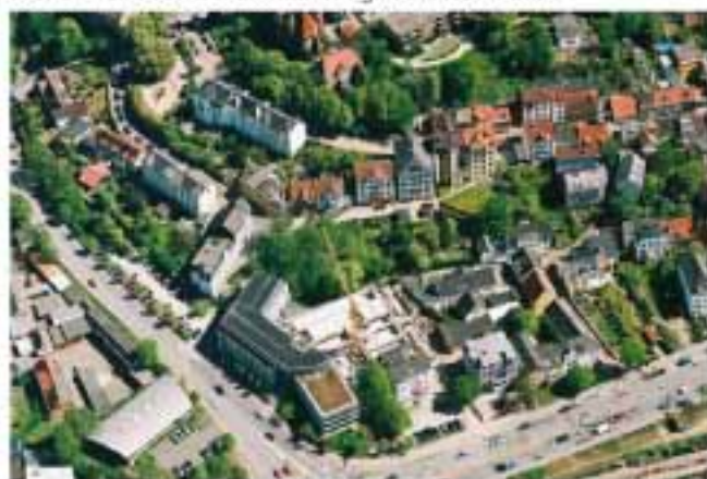
2007 Luftbild von der Einmündung in die Nordstraße
