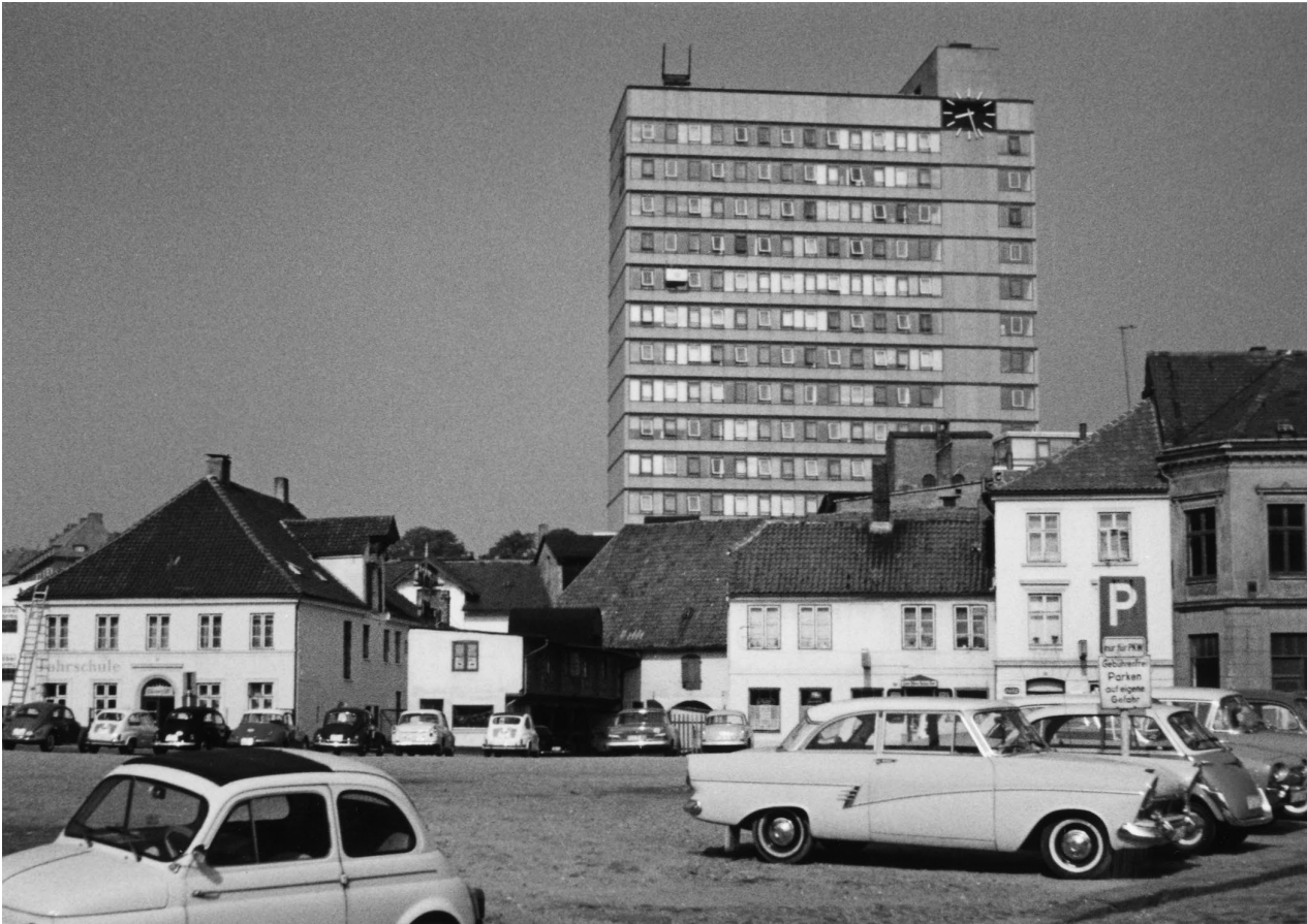
Abb. 13 Blick über das Abbruchgebiet an der Töpferstraße auf die noch stehenden Gebäude Rote Straße 42/38/40 um 1964. Im Hintergrund erhebt sich das Neue Rathaus.
