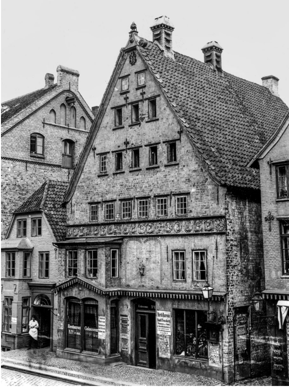
Abb. 135 Große Straße 12, Renaissance-Giebelhaus, abgebrochen 1887
