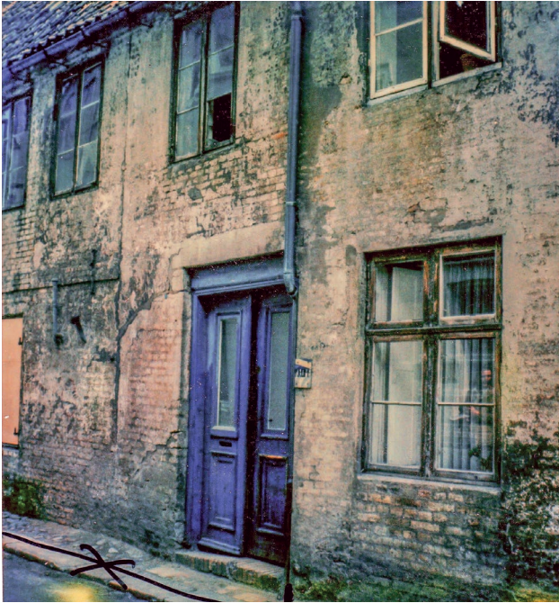
Abb. 3 Wohnhäuser in der Süderfischerstraße, Juni 1983
