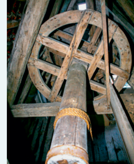
Aufzugswinde im Dachboden des Eckenerhauses, Norderstraße 8
