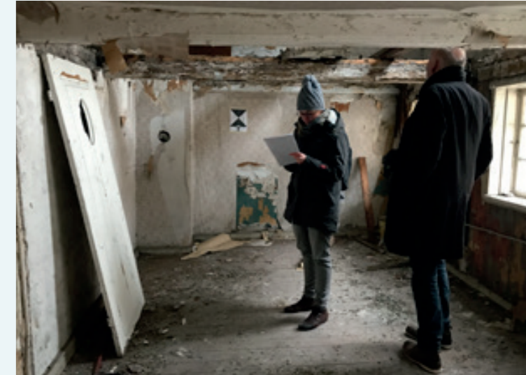
1. Obergeschoss im Tonnendachflügel vor und nach der Sanierung
