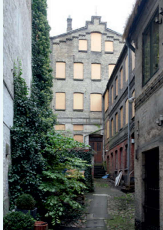
Quergebäude am westlichen Hofende
