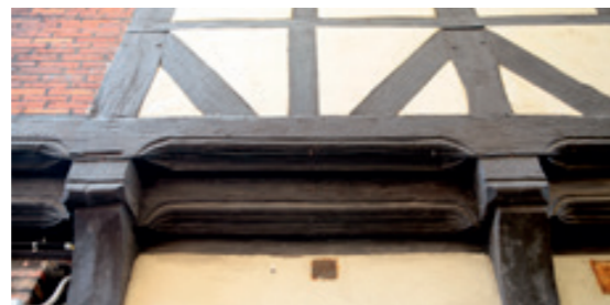
Norderstraße 78, vorkragendes Obergeschoss mit Renaissance-Fachwerk um 1600
