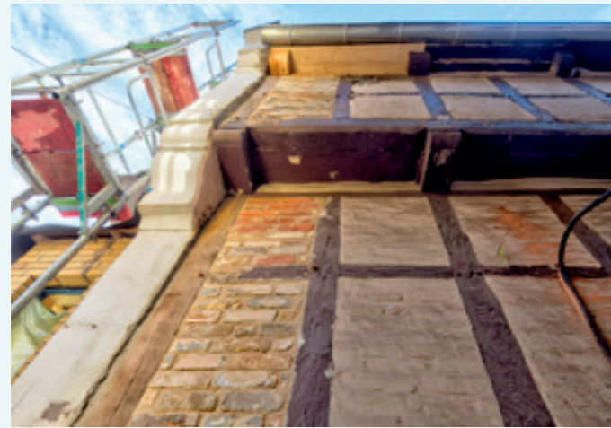
Nordansicht des Vorderhauses, auskragende Deckenbalken mit Karniesprofil
