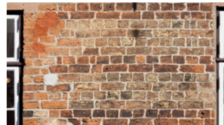
Farbiger Schichtenwechsel im Mauerwerk, hier am Beispiel des Kaufmannshofes Holm 19/21
