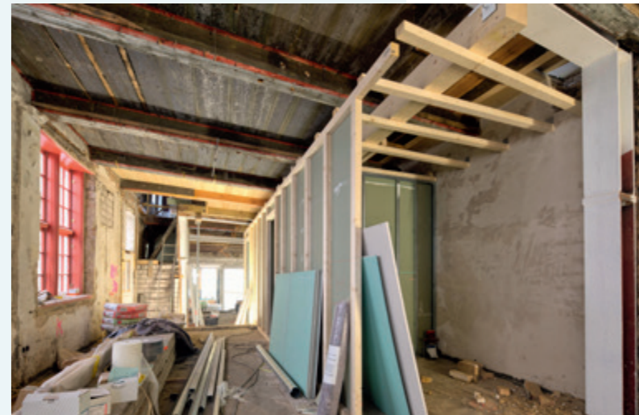
Pesel nach Osten gesehen, während des Einbaus der Toilettenräume, Dezember 2018
