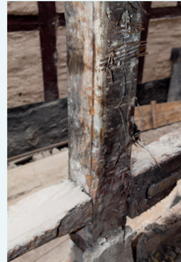
Der Falz im Fachwerkständer des Vorderhauses ist ein Hinweis auf ein Fenster, das an dieser Stelle eingesetzt war – der Ständer diente als Fensterzarge und war mit einer Profilierung versehen.
