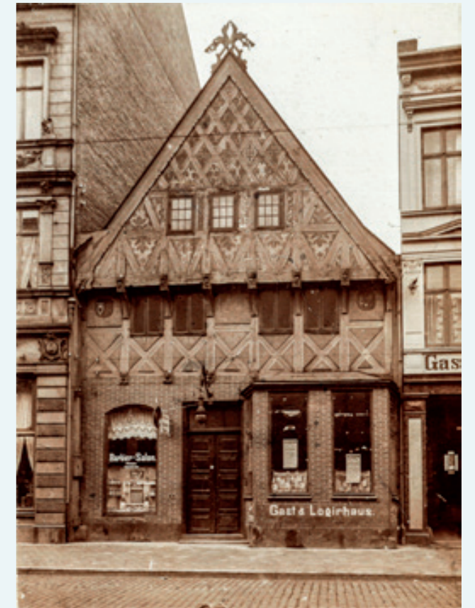
Große Straße 57, vorkragender Fachwerkgiebel, abgebrochen vor 1910
