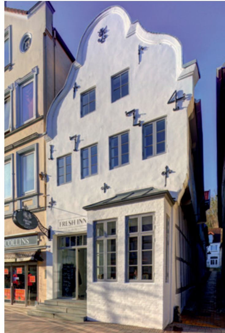
Fassade nach Fertigstellung 2020
