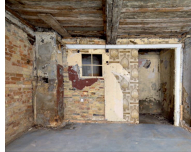
Raum im Erdgeschoss des Rückflügels, Juli 2017. Der hintere Raum erhielt nur Licht über ein Fenster zum vorderen Raum.
