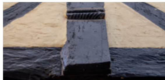
Ständerüberblattung am Hofgebäude Große Straße 6
