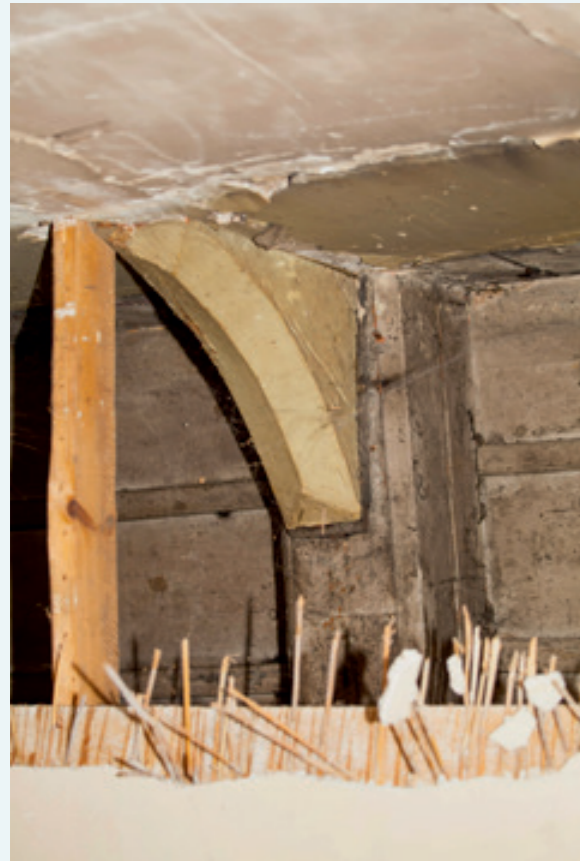
Kopfband in der Diele des Vorderhauses mit diamantförmiger Vorderseite
