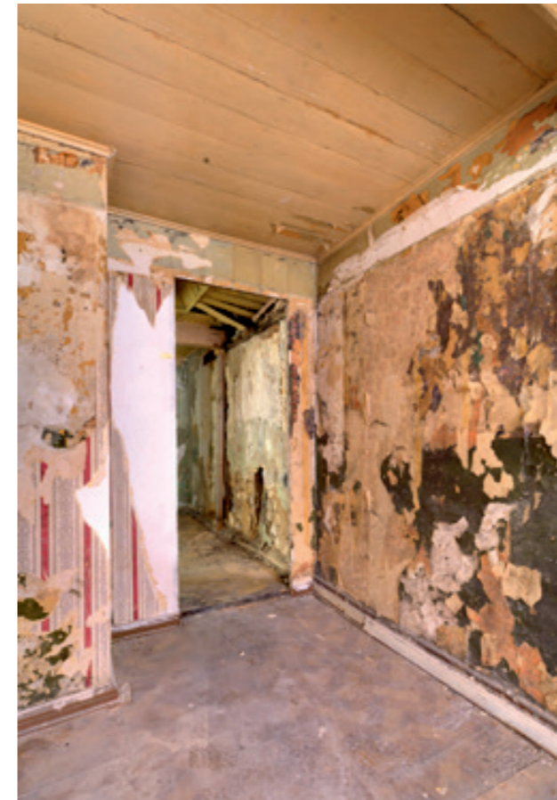
Raum im Obergeschoss des Rückflügels, Juli 2017
