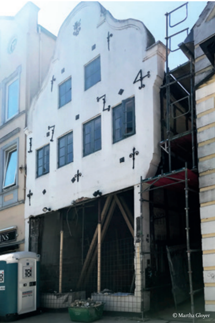
Fassade in der Bauphase 2018
