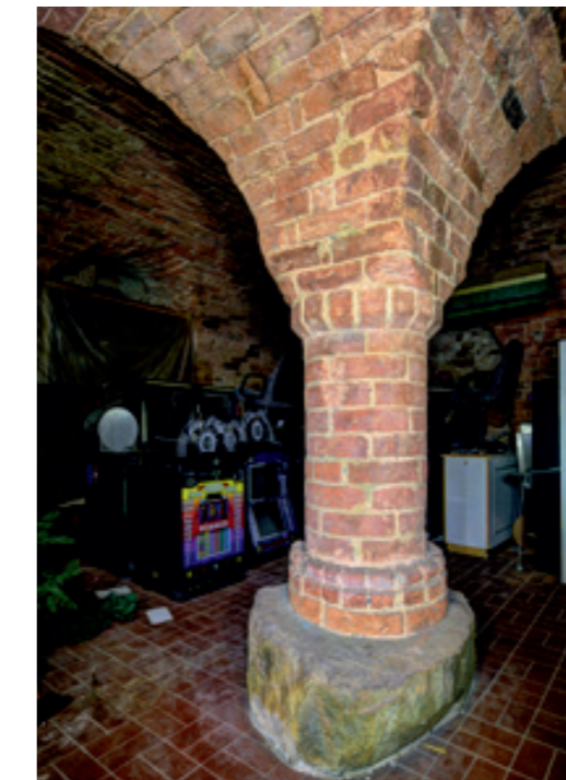
Gemauerter Rundpfeiler im Keller des Vorderhauses Holm 47, Zustand 2019
