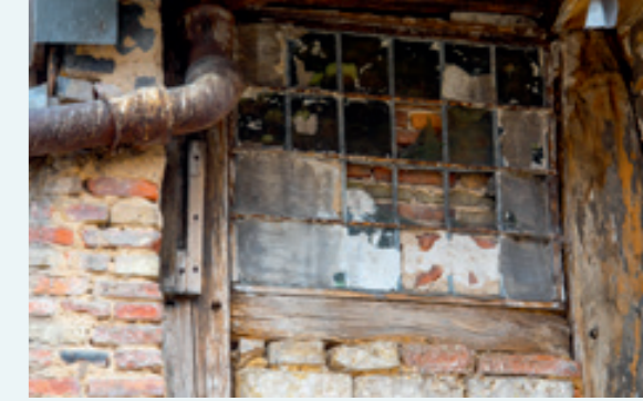
Originales Renaissancefenster in der Seitenwand des Vorderhauses Angelburger Straße 15, August 2019
