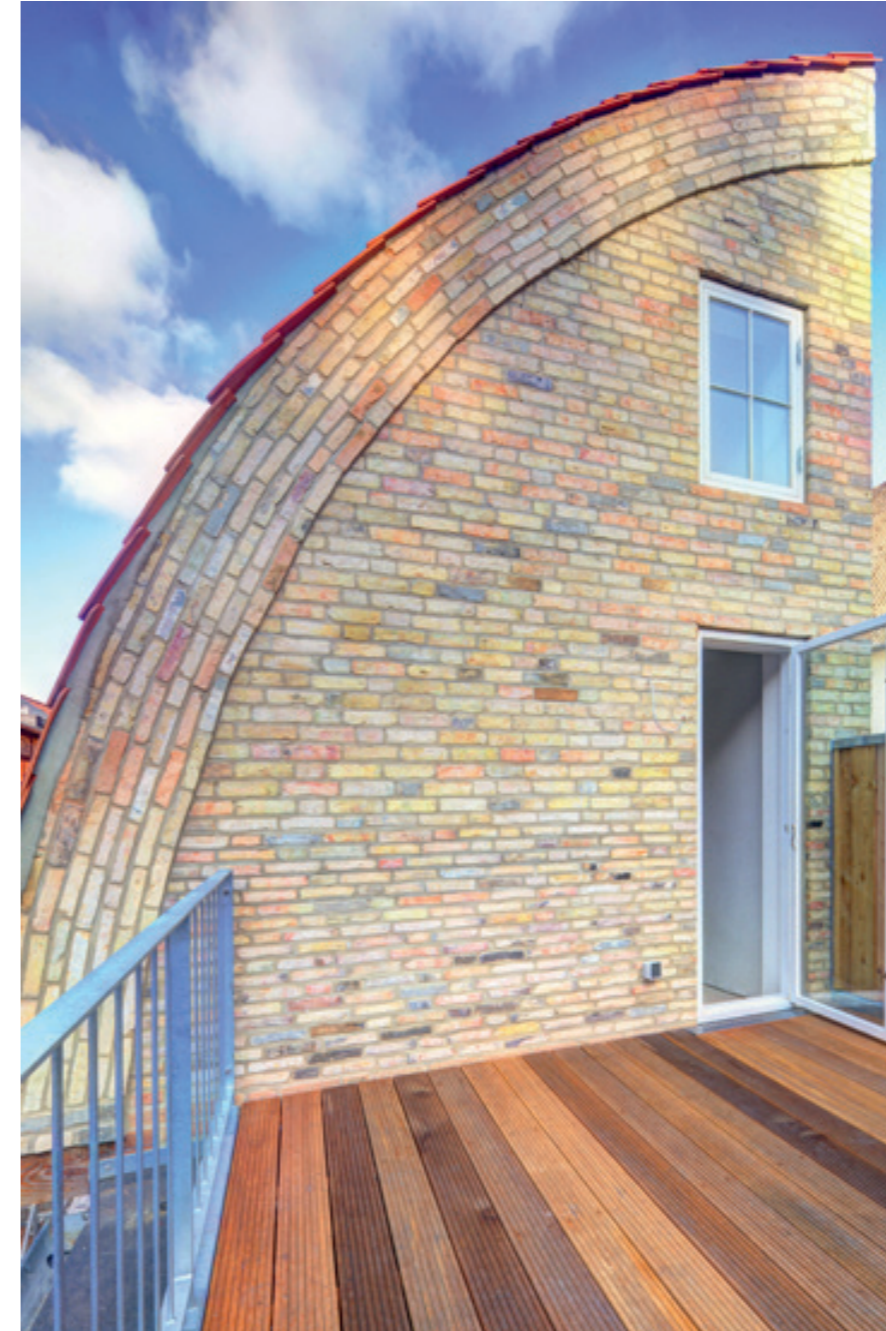
Tonnendachflügel, Dachterrasse und Galerie im Dachgeschoss
