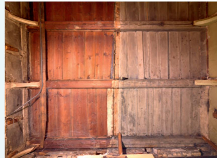
Nach Freilegung der Decke in der Diele wurde die frühere Aufteilung deutlich sichtbar. Juli 2017
