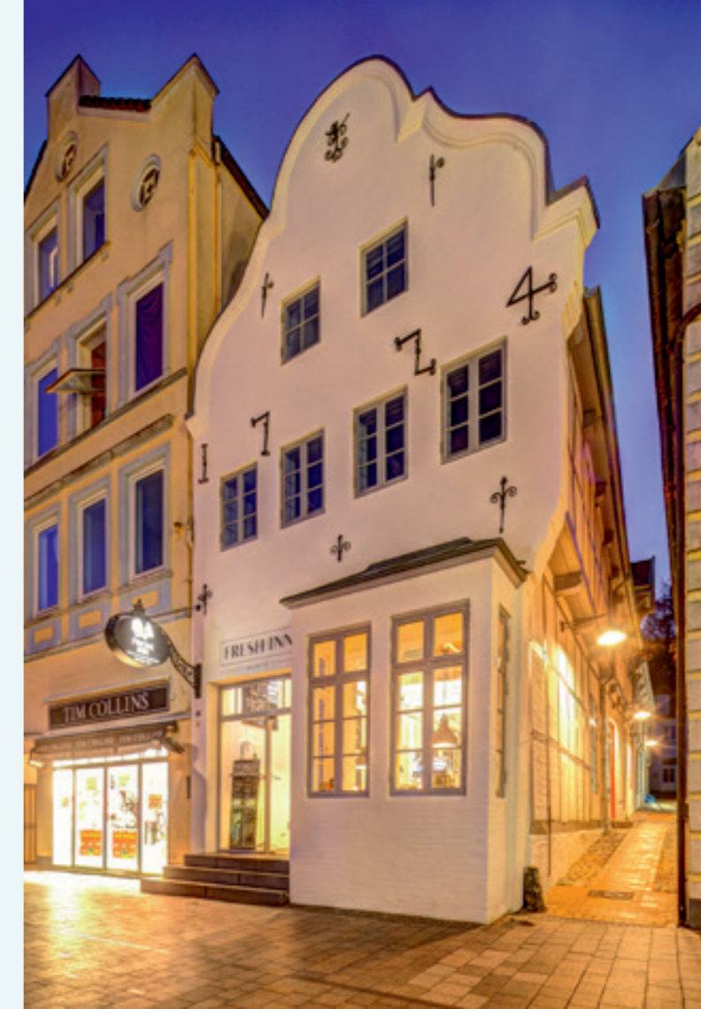
Das „Fresh Inn“ ist ein neuer Anziehungspunkt in der Großen Straße geworden. Der Tisch in der Utlucht wird zu einem Lieblingsplatz. Januar 2020
