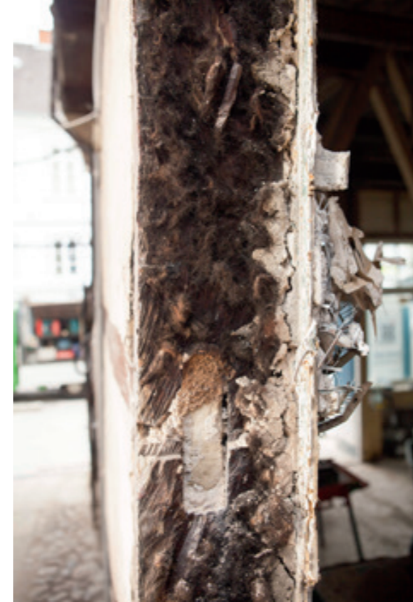
Nördliche Außenwand des Vorderhauses, freigelegter Fachwerkständer, Juli 2018. Das Zapfenloch zeigt die Position eines Riegels an, der später entfernt wurde. Auf dem Ständer Tierhaar, das zur Abdichtung zwischen Holz und Ausfachung diente.
