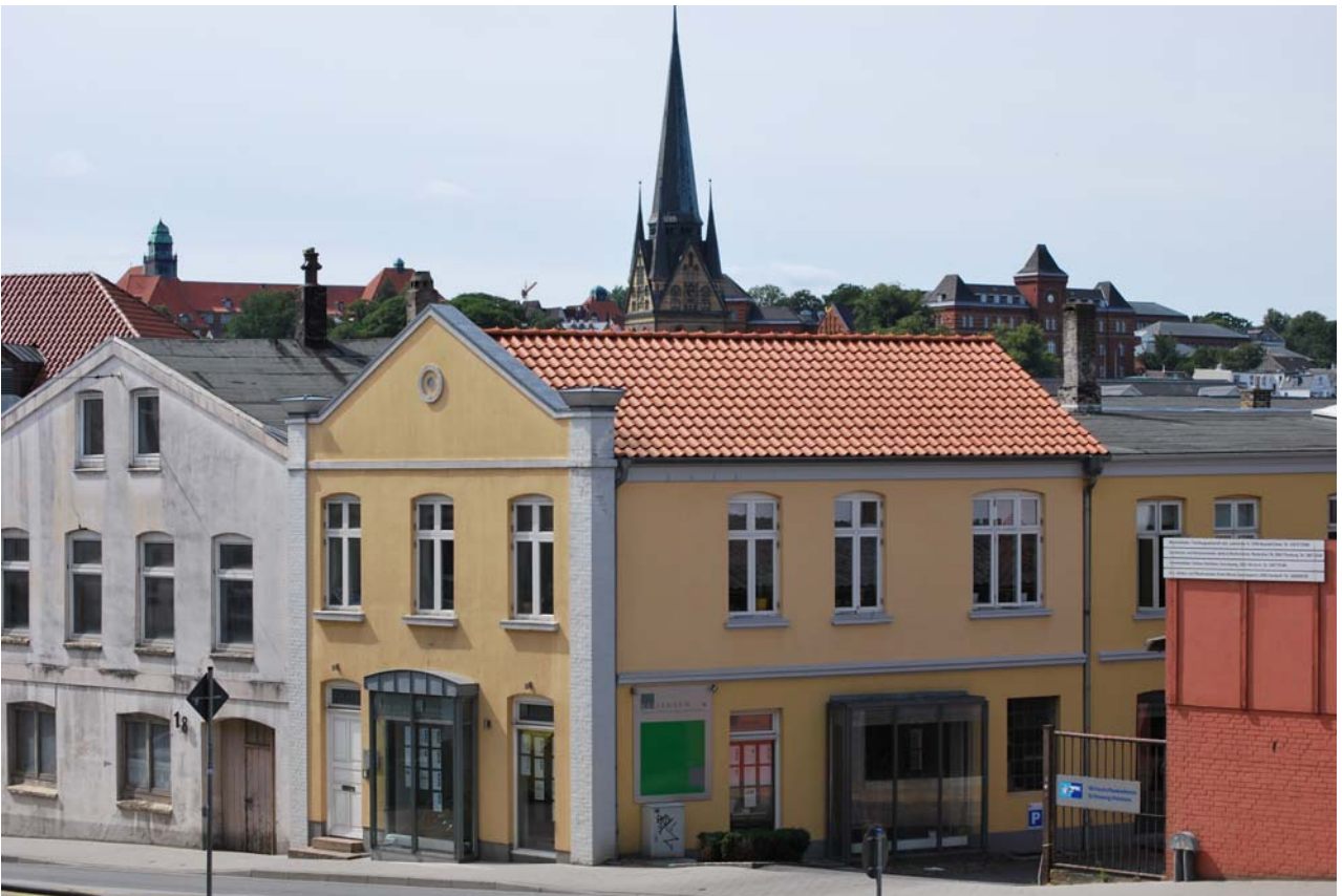
2007 Heinrichstraße 16 „Peco-Höfe“ nach der Sanierung
