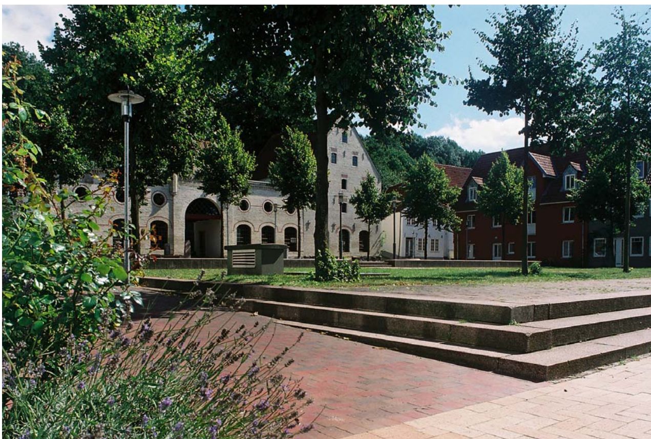
2007 Die neue Platzgestaltung mit dem denkmalgeschütztem Torgebäude des Margarethenhofes
