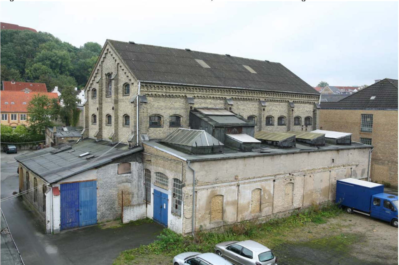
2007 Die ungenutzte Ölmühle vor Beginn der Abbruch- und Modernisierungsmaßnahmen Wilhelmstraße 7 – 9
