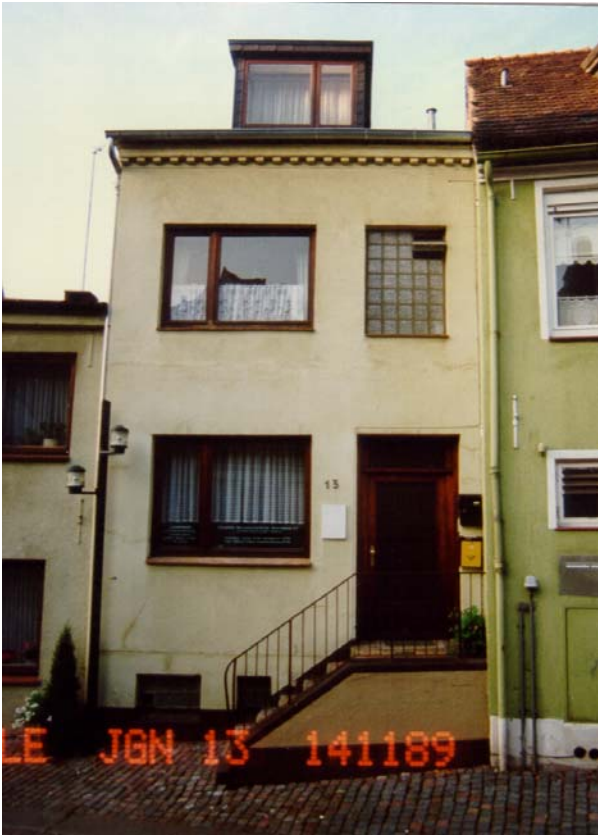
1989 St.-Jürgen-Straße 13 vor der Sanierung
