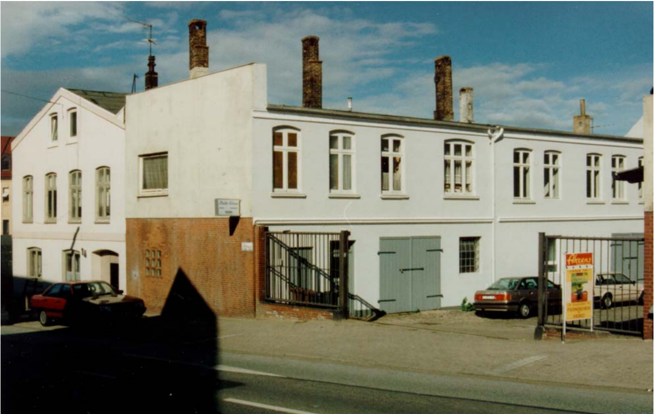
1989 Heinrichstraße 16 „Peco-Höfe“ vor der Sanierung
