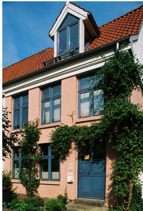
2007 St.-Jürgen-Straße 56 nach der Sanierung
