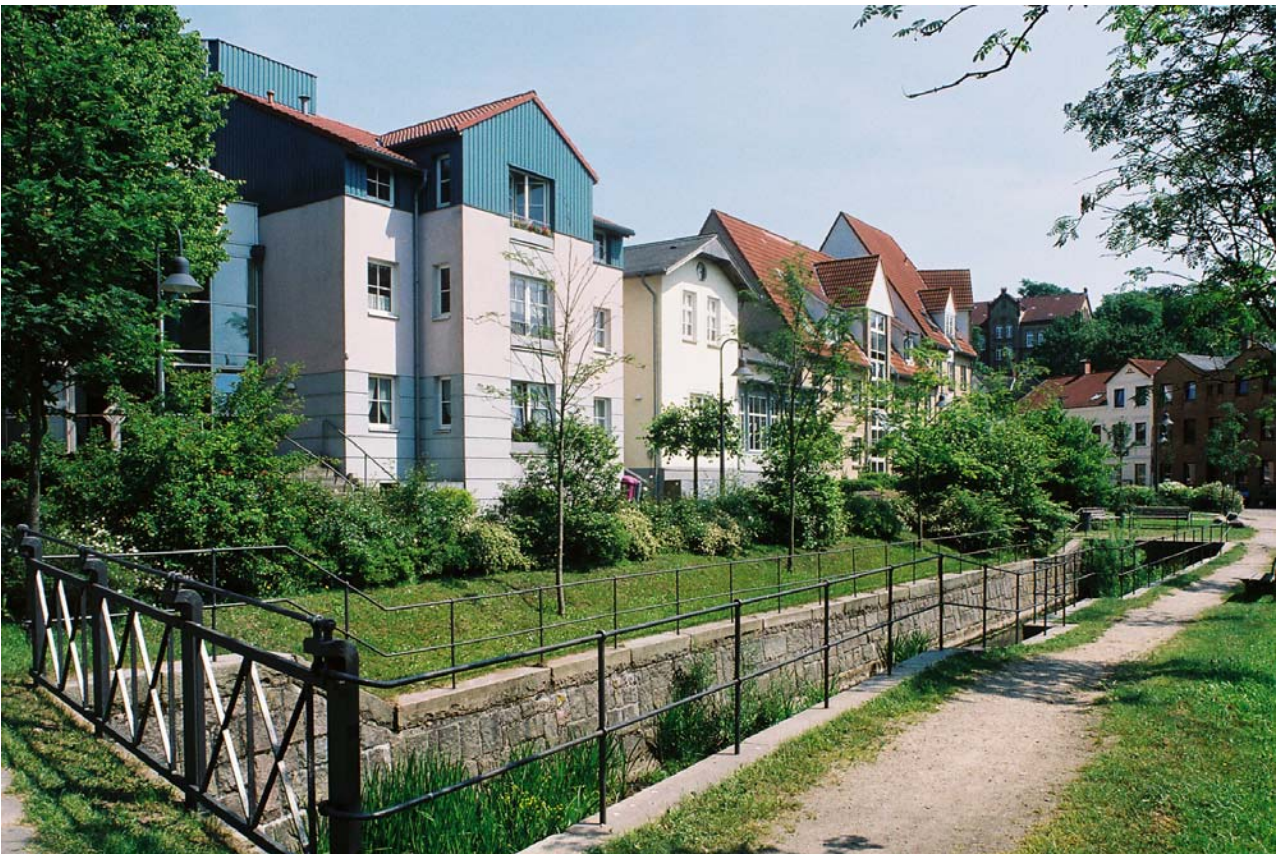
2009 Am Lautrupsbach mit offen gelegtem Bachverlauf, Wegeverbindung und Neubau eines Seniorenheimes
