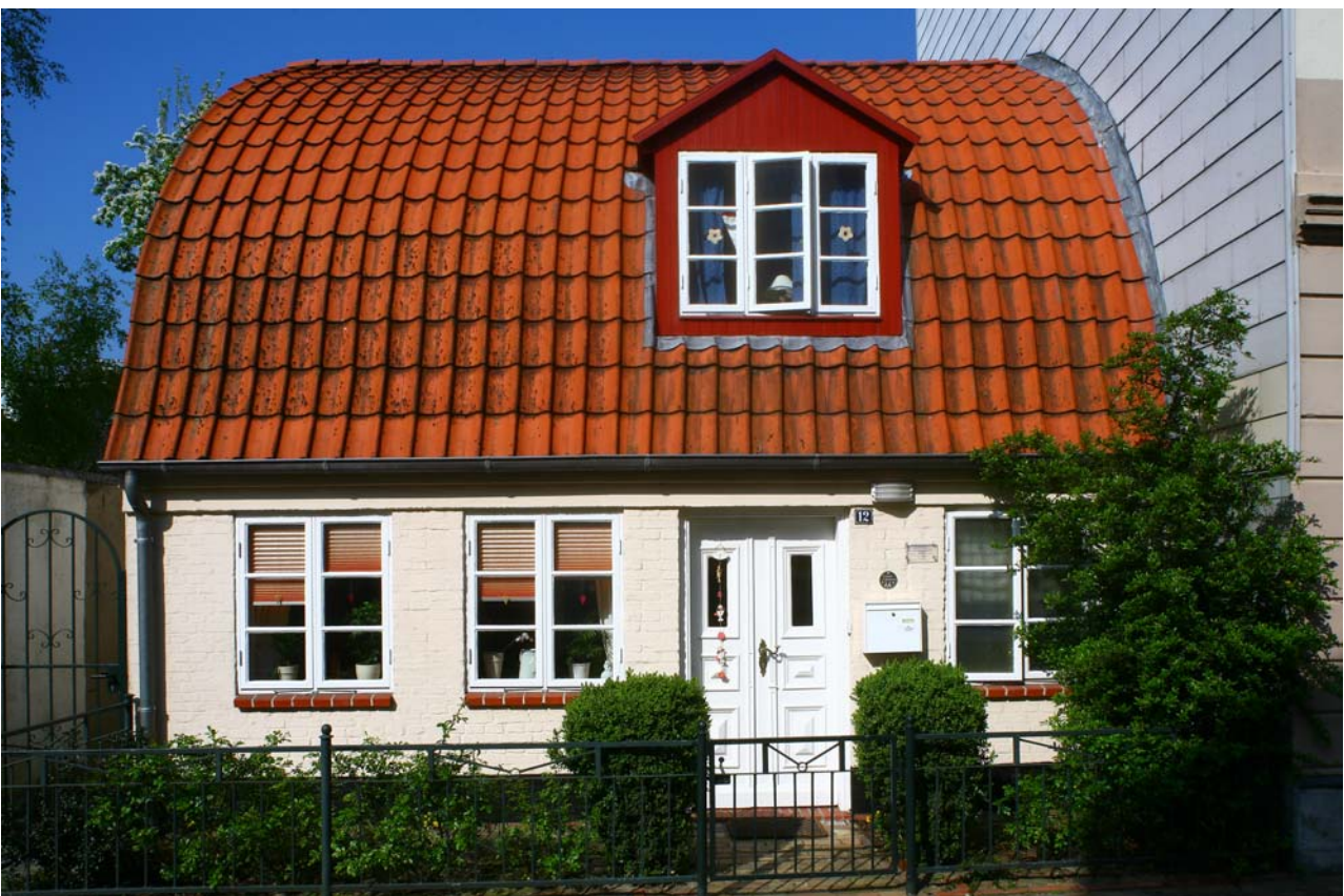
2007 Teichstraße 12 nach der Sanierung
