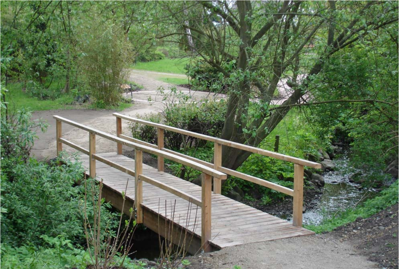
2009 Die neu angelegte Wegeverbindung entlang des Baches führt über das Grundstück eines Seniorenheimes
