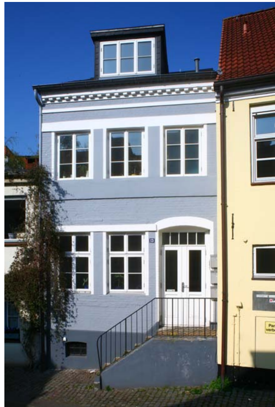
2007 St. Jürgen-Straße 13 nach der Sanierung
