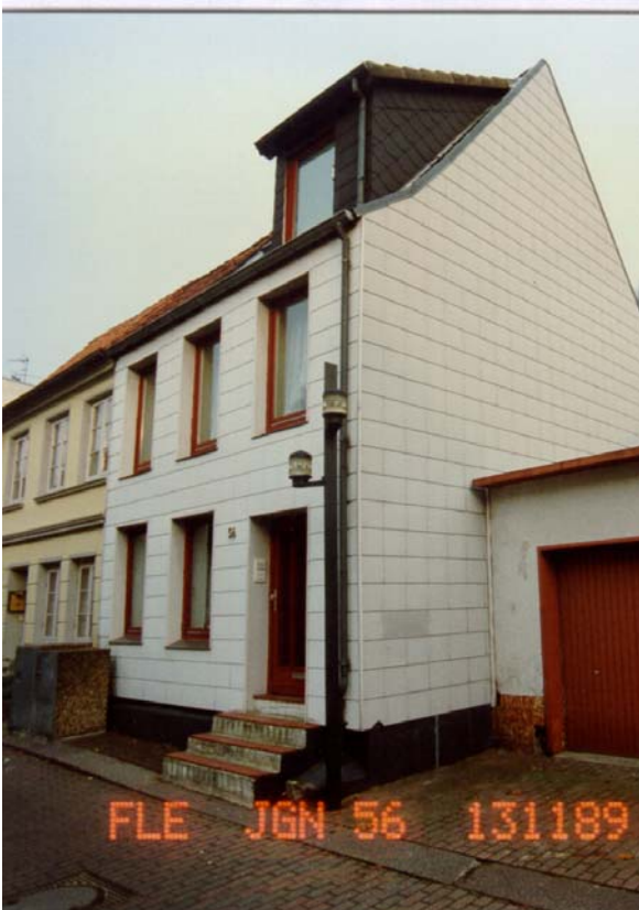
1989 St.-Jürgen-Straße 56 vor der Sanierung
