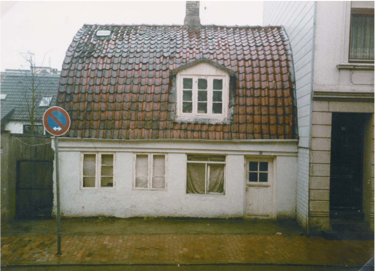
1989 Teichstraße 12 vor der Sanierung
