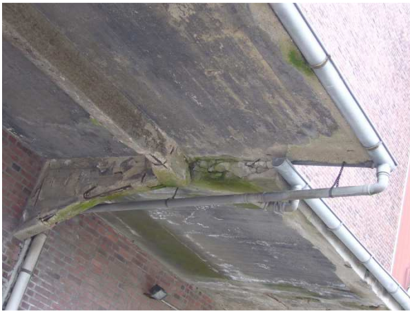
Feuchtigkeitsschäden, Mängel an Dächern (Harniskai 4, Harniskai 22)
