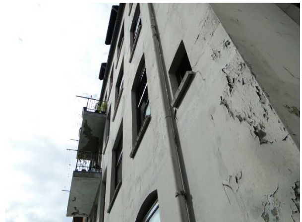
Ungeschützte Fassade, nach Abbruch unterlassene Abschlussarbeiten erzeugt Feuchtigkeitsschäden (Ballastbrücke 1), Fassadenabplatzungen und Feuchtigkeitsschäden (Ballastbrücke 10)
