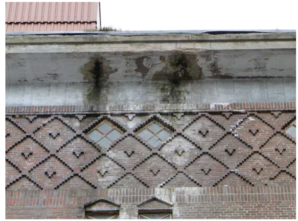
Feuchtigkeitsschäden, Mängel an Dächern (Harniskai 4, Harniskai 22)
