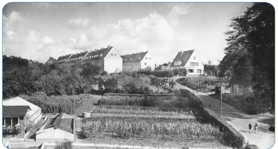
Kleingartenidyll: Hinter der Einmündung des Bohlbergs sind die ERP-Häuser Mühlenholz 15-35 (1950/51) und 20-22 (1951/52) zu erkennen.
