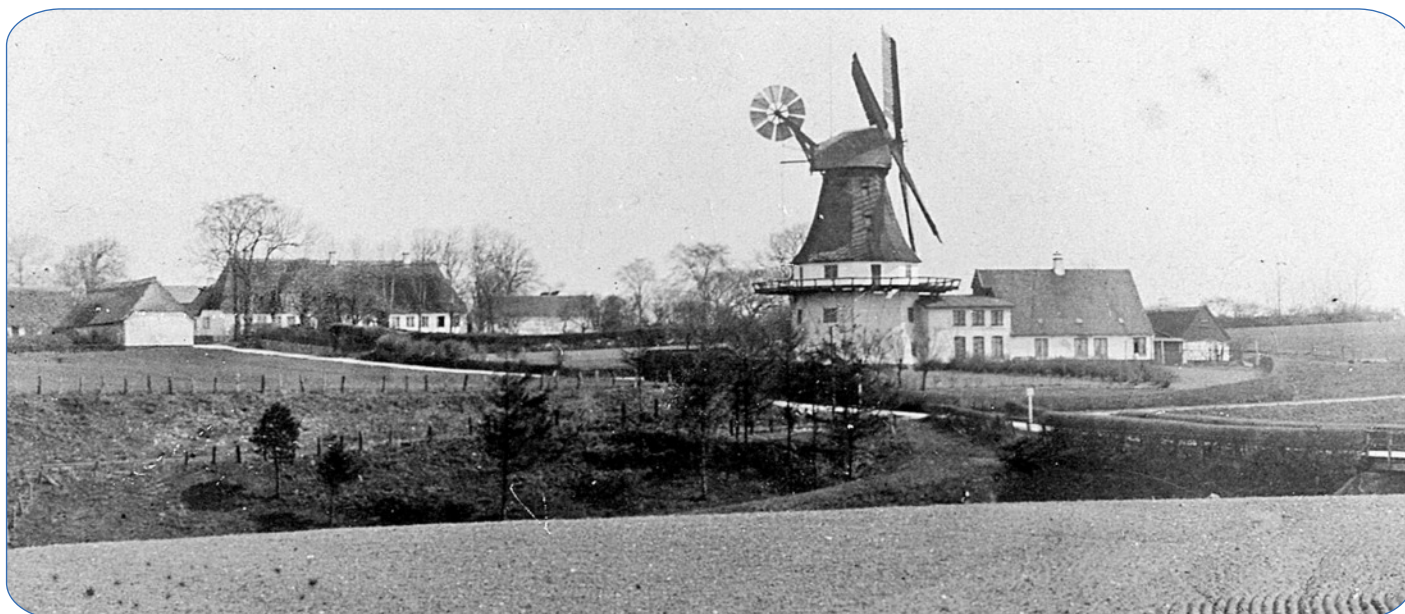
Blick von der Glücksburger Straße über das mittlere Lastrupstal auf die alte Mühle Fruerlund, um ca. 1900. Die Mühle ging 1912 durch einen Brand verloren. Stadtarchiv
