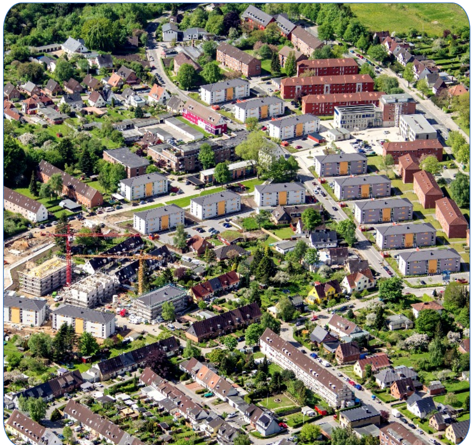
Umbauarbeiten im Überblick: Das einstige Siedlungsgebiet bekommt ein neues Gesicht.
