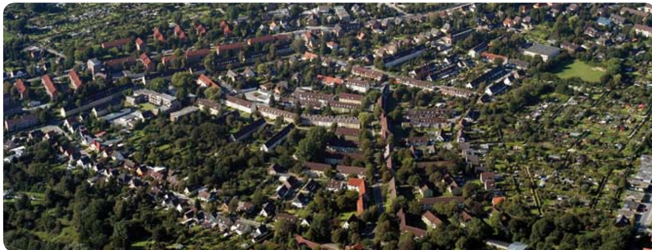
Quartier mit Tradition: Fruerlund-Süd wird in den kommenden vier Jahren fit für die Zukunft gemacht. Rund 60 Millionen Euro werden dafür in Sanierung und Neubau von Wohnungen, neue Straßen und einen ausgedehnten Park investiert. FOTO: Norddeutsche Luftbild, Barmstedt
