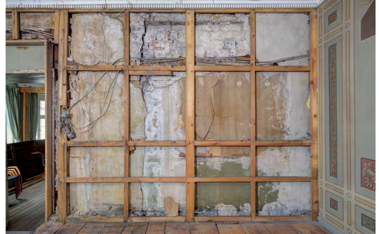
ECKENERHAUS NORDERSTRASSE 8-10 SICHERUNG UND ÖFFNUNG EINER INNENWAND FOTOS: EIKO WENZEL | STADT FLENSBURG
