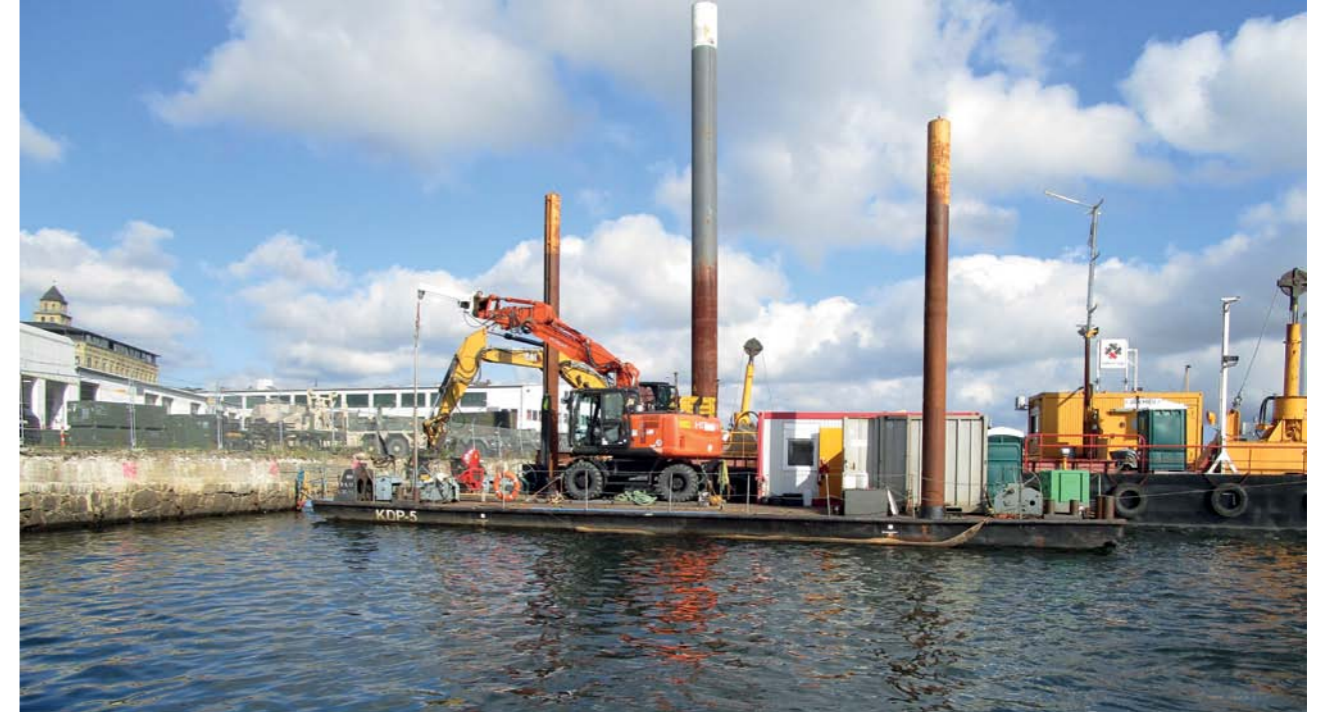
FÖRDEPROMENADE BAUARBEITEN AM NORDERTORKAI
