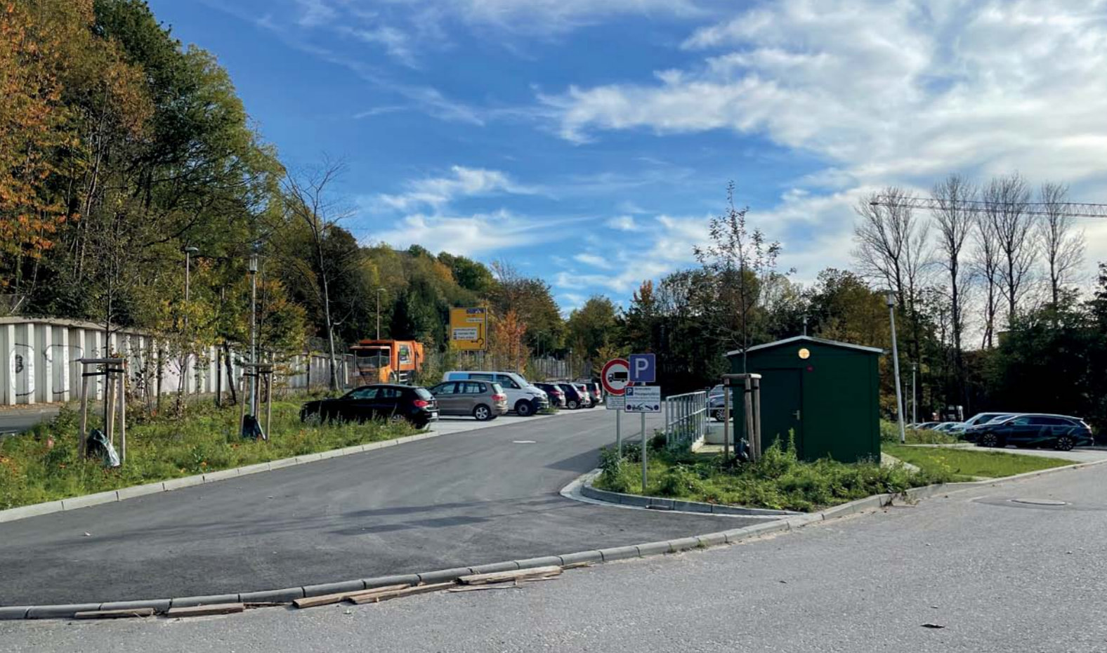
WOHNPROJEKT FREILAND ERSCHLIESSUNGSSTRASSE MIT PARKPLATZ
