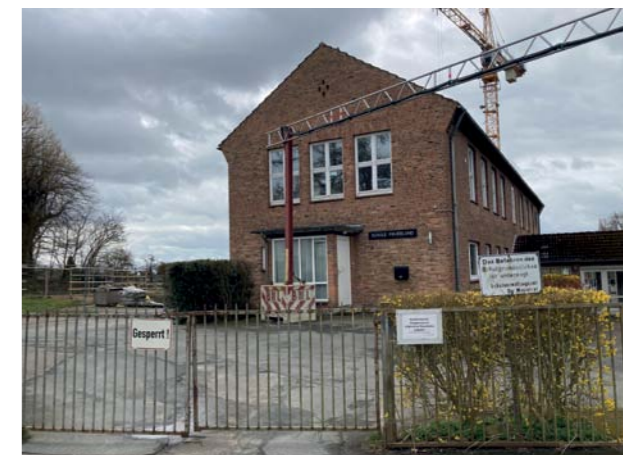
SCHULE FRUERLUND ZU BEGINN DER BAUARBEITEN FOTO: JÖRG OESTREICH
