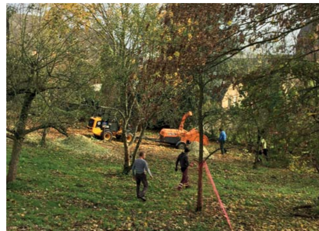
BERGMÜHLE NEUGESTALTUNG DES GARTENS FOTO: JÜRGEN BEUSE
