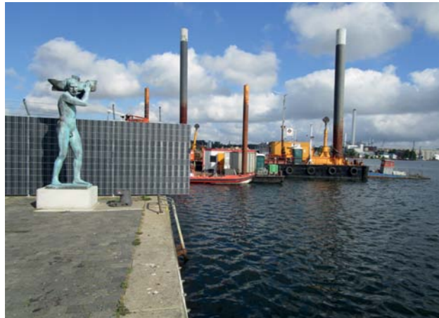
FÖRDEPROMENADE BAUARBEITEN AM NORDERTORKAI
