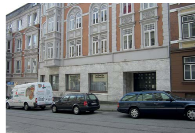
TOOSBÜYSTRASSE 7 IM JAHR 2014 VOR DER SANIERUNG DER STRASSENFASADE
