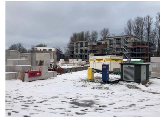
WOHNPROJEKT FREILAND FORTSCHRITT DER BAUARBEITEN IM DEZEMBER 2021
