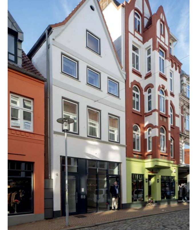
ROTE STRASSE 12 DAS GEBÄUDE IN DER BELEBTE ROTEN STRASSE STEHT SEIT LÄNGERER ZEIT LEER.
