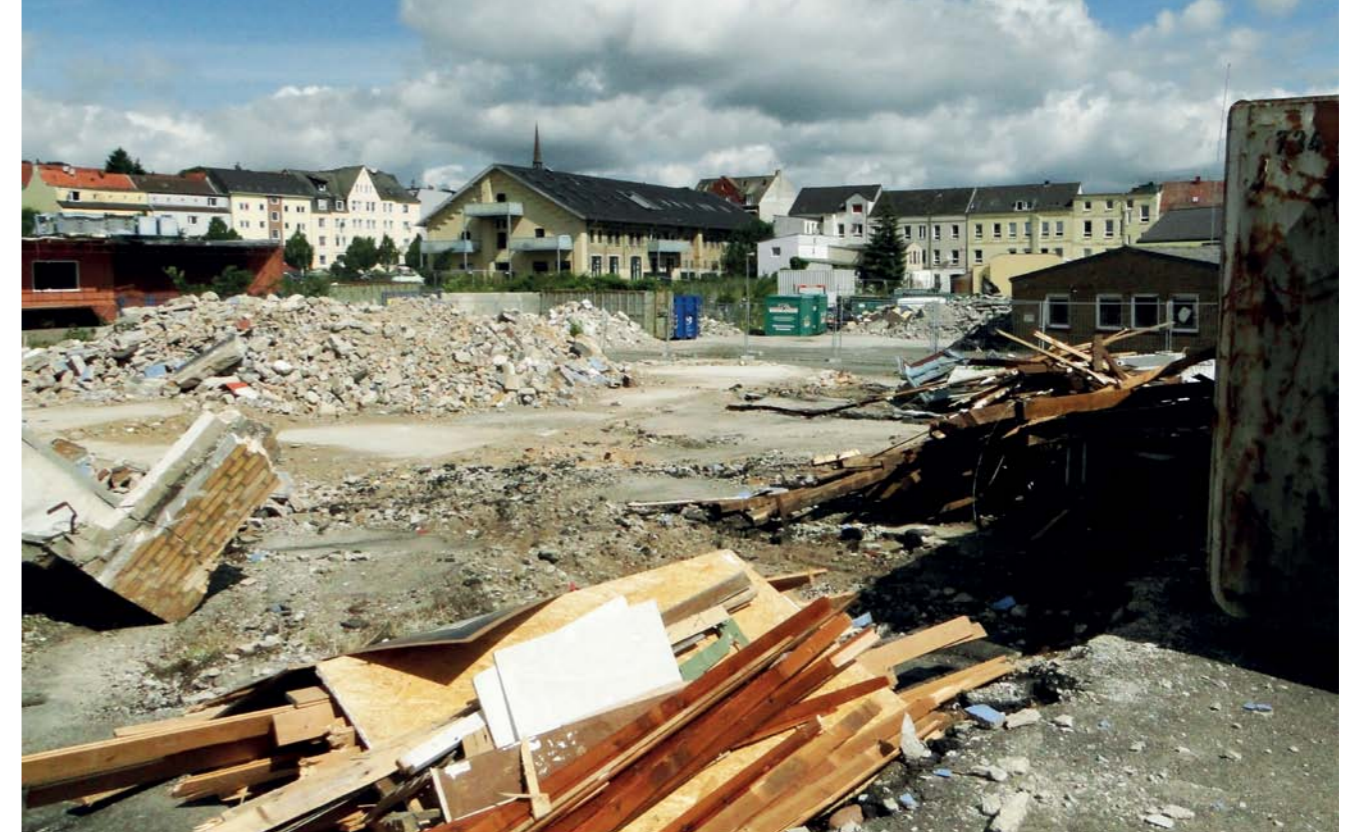
2020 Abbruchmaßnahmen Wohnquartier Schwarzenbachtal
