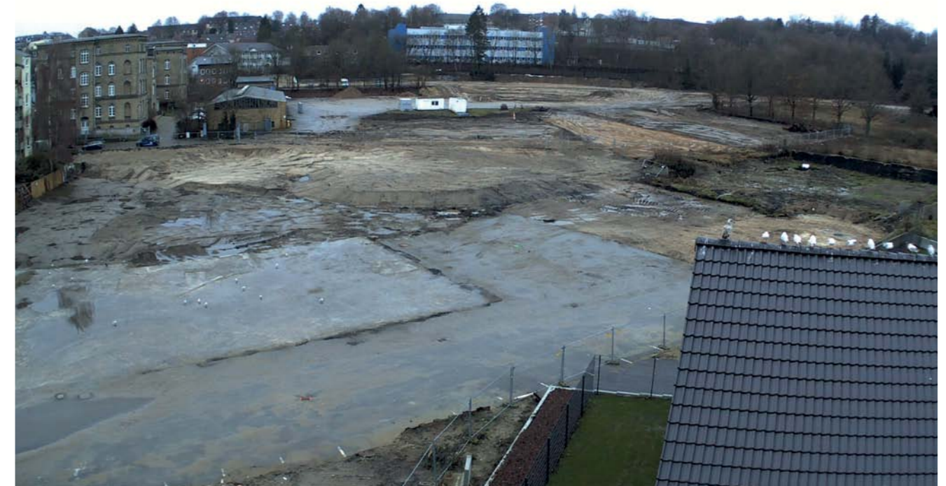
2020 Abbruchmaßnahmen Wohnquartier Schwarzenbachtal im Dezember
