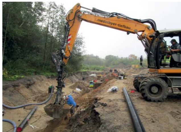
2019 Erschließung Wohnprojekt Freiland
