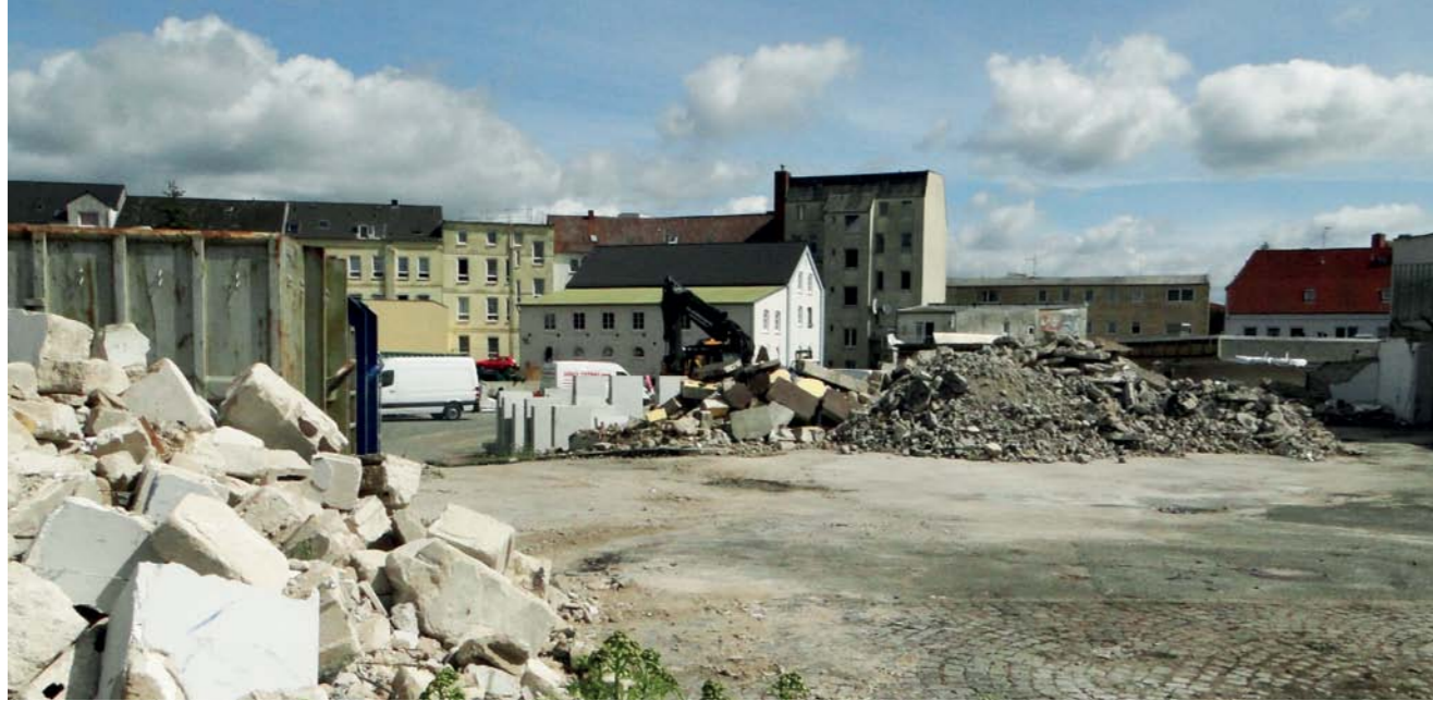
2020 Abbruchmaßnahmen Wohnquartier Schwarzenbachtal
