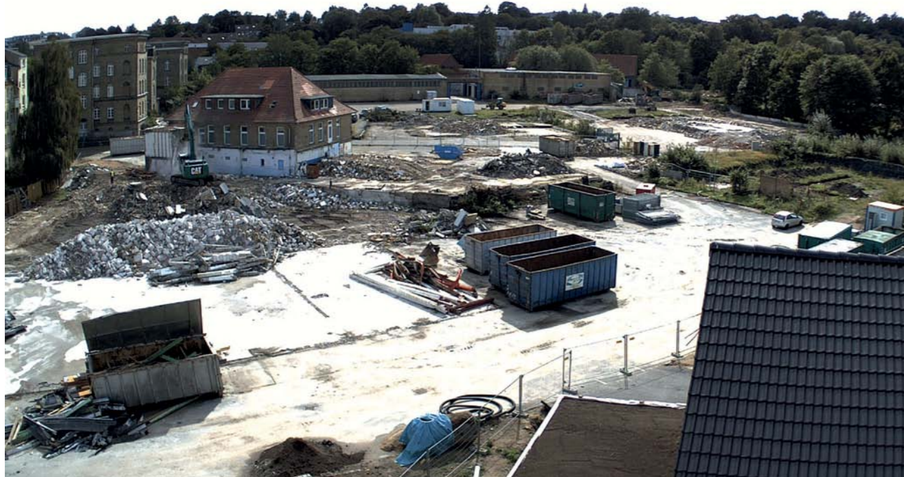
2020 Abbruchmaßnahmen Wohnquartier Schwarzenbachtal im August
