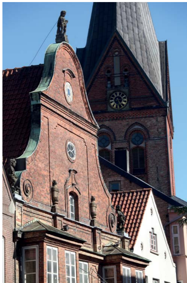
2018 Fassade Eckener Haus
