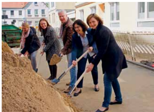
2019 Erster Spatenstich in der Bergstraße.
