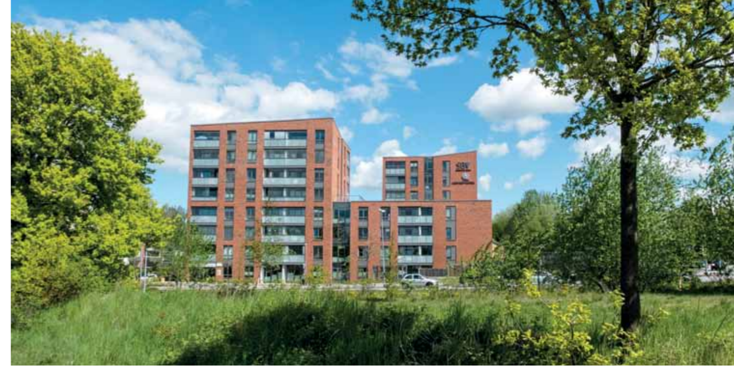
Stadtumbau West Wasserlooser Weg/Breedlandweg, Neubau Seniorenwohnanlage
