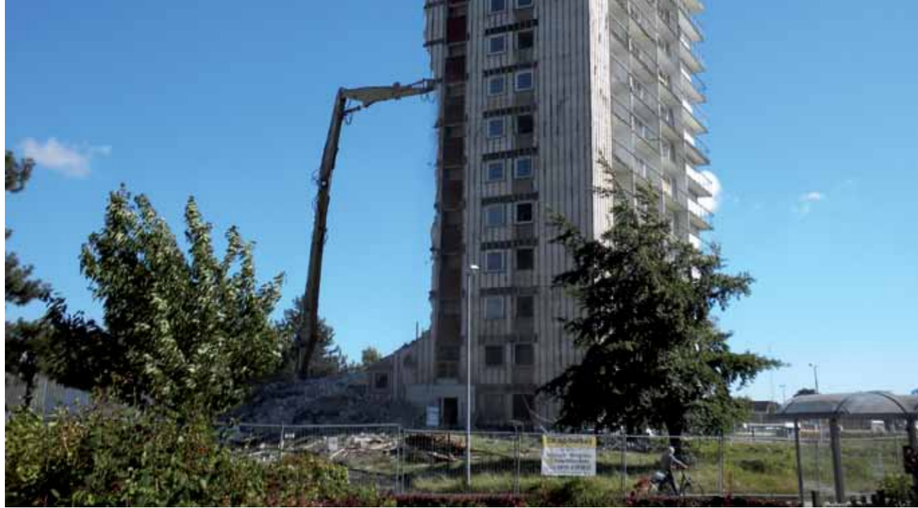
Stadtumbau West Wasserlooser Weg/Breedlandweg, Abbruch Hochhaus Wasserlooser Weg 2
