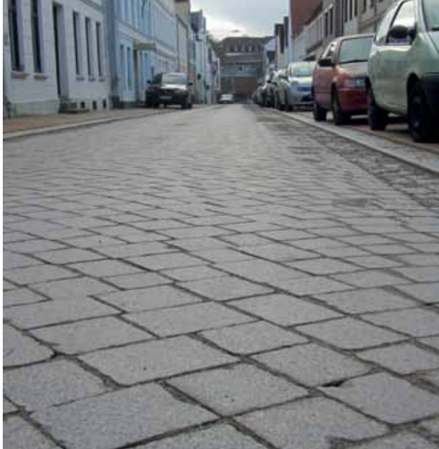
2019 Neue Fahrbahn aus Granitsteinen in der Bergstraße
