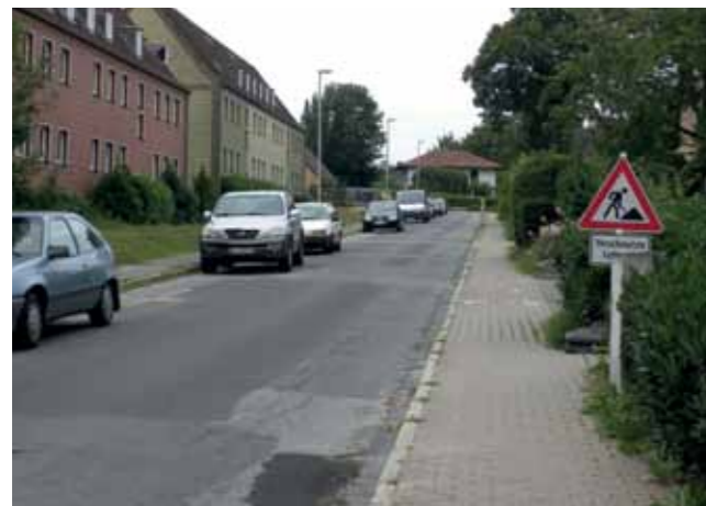
2010 Ausgangssituation im Mühlenholz
