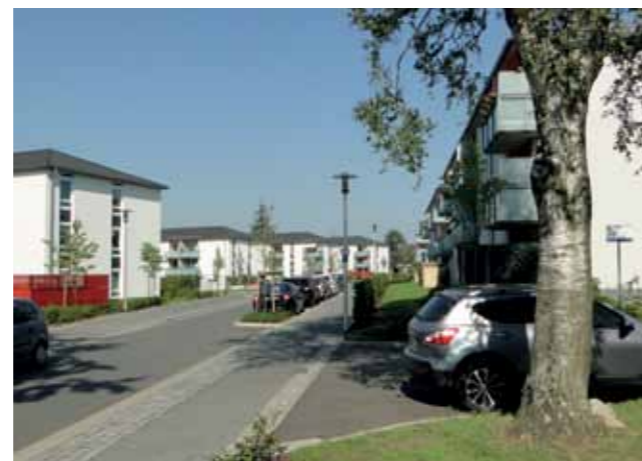
2015 Sanierte Ostlandstraße mit Vorrang für Fußgänger, Blindenleitlinien und neuer Beleuchtung
