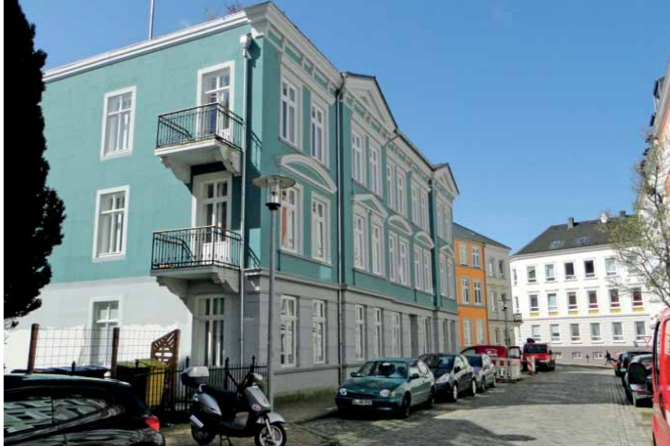
Instandgesetzte Straßenfassade der Schloßstraße 43 im Mai 2018
