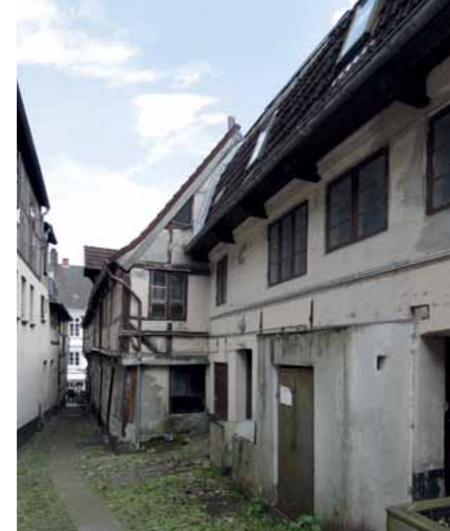
2016 Beengte Hoffläche der Großen Straße 73
