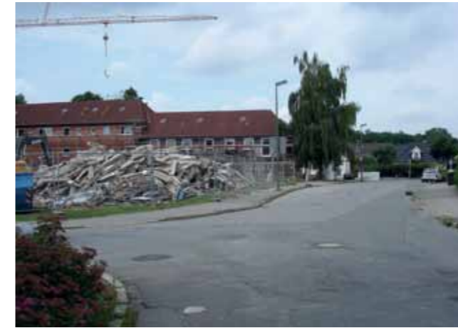
2010 Beginn der Abbrucharbeiten im Mühlenholz
