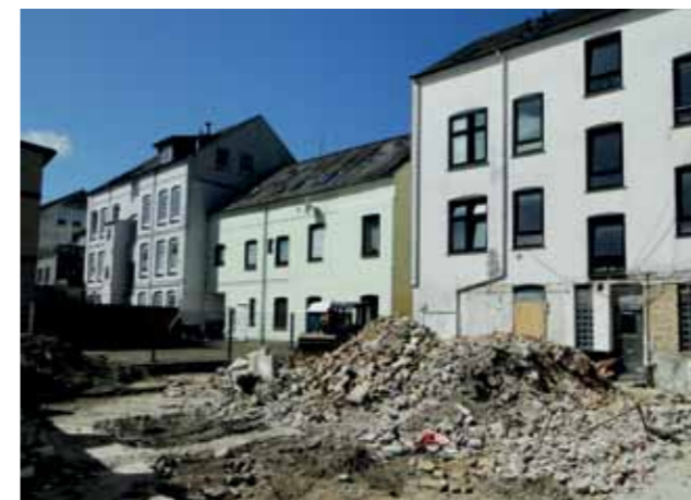
2018 Abbrucharbeiten im Innenbereich
