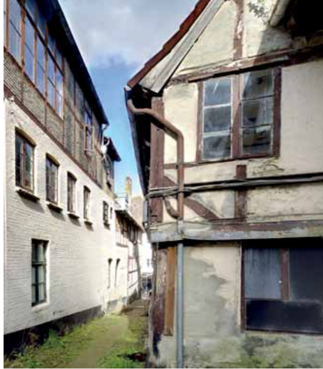
Hofsituation Große Straße 73
